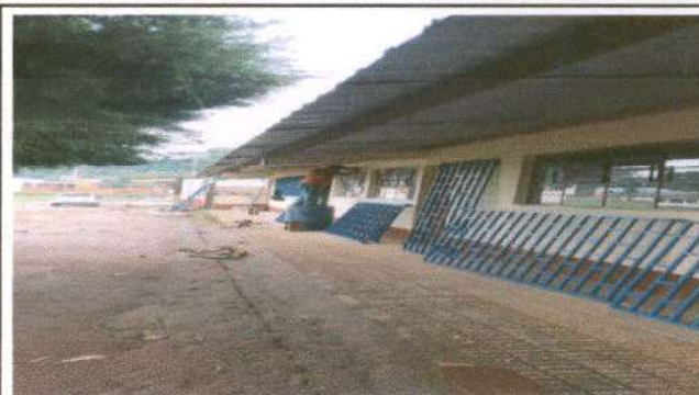
Foto 2: Sustitución de balcones de metal 25 M2
