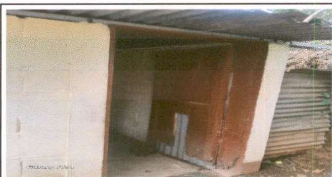
Foto 5: Sustitución de puerta
