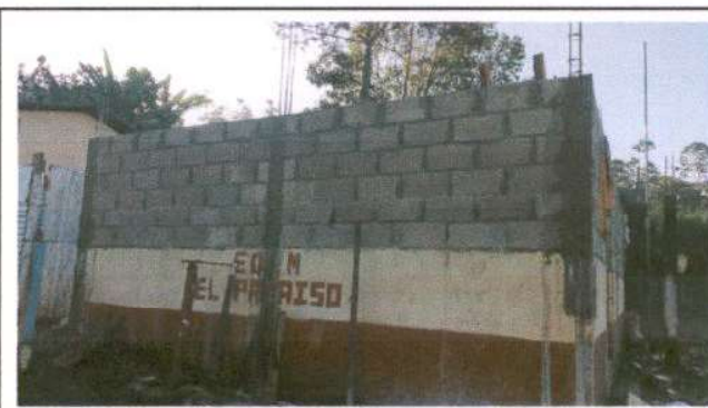
Foto 4: Reparación de muro perimetral de block 50 M2
